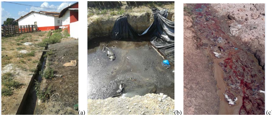
Figura 3: (a)- Vala que encaminha resíduos líquidos para o buraco localizado a jusante do matadouro (b) e vísceras e sangue dispostos no próprio solo. Fonte: Autores (2017).
